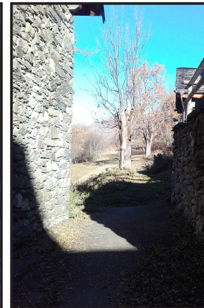
Cheminement piéton en direction de la zone de l'OAP
